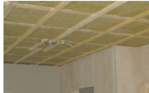
Abb. 57 Einbau einer Unterdeckendämmung aus Mineralwolle
