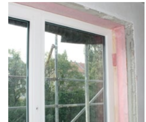
Abb. 95 Einbau eines neuen Fensters mit Dichtklebeband
