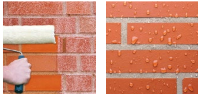
Abb. 82 / 83 Auftragen des flüssigen Hydrophobierungsmittels auf ein Klinkermauerwerk und der sog. Abperleffekt
