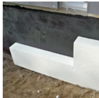
Abb. 69 Angebrachte Perimeterdämmung im Sockelbereich
