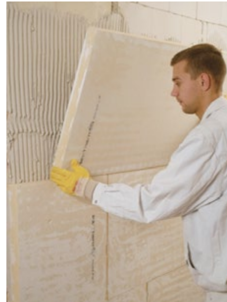
Abb. 84 / 85 Vollflächiges Verkleben einer kapillaraktiven Innendämmung
