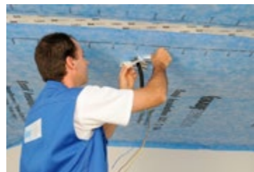
Abb. 47 Verkleben von Kabeldurchführungen mit vorgefertigten Kabel-Manschetten
