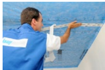
Abb. 46 Verkleben der Folienstöße mit speziellem Kleband
