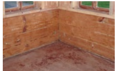
Abb. 15 Rauminnenecke einer Außenwand aus Holz-Blockbohlen
