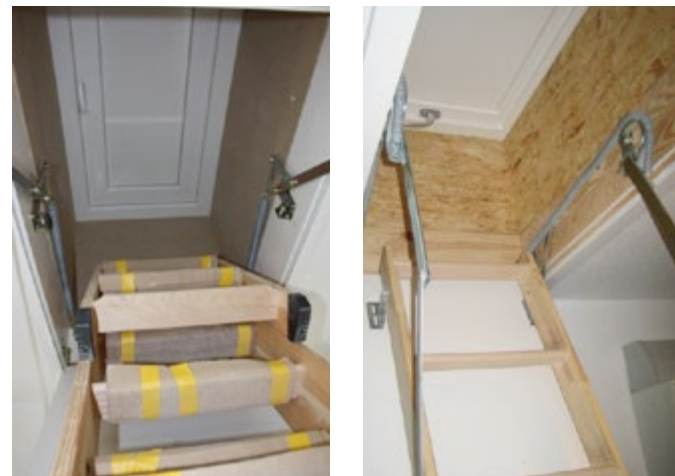
Abb. 58 / 59 neu eingebaute Bodentreppe mit zusätzlich gedämmter Bodenluke
