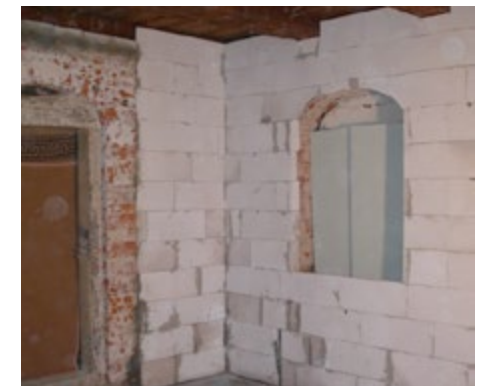
Abb. 87 Einsatz von Mineralschaumplatten mit einer Flankendämmung an der einbindenden Innenwand
