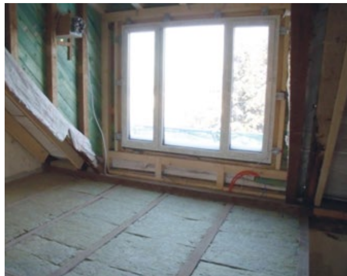
Abb. 56 Zwischensparrendämmung mit Mineralwolle
