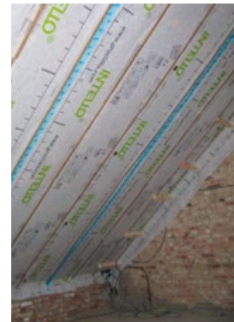
Abb. 30 - 32 Vergrößerung des Sparrenzwischenraums durch seitlich angebrachte Sparrenexpander aus Holz
