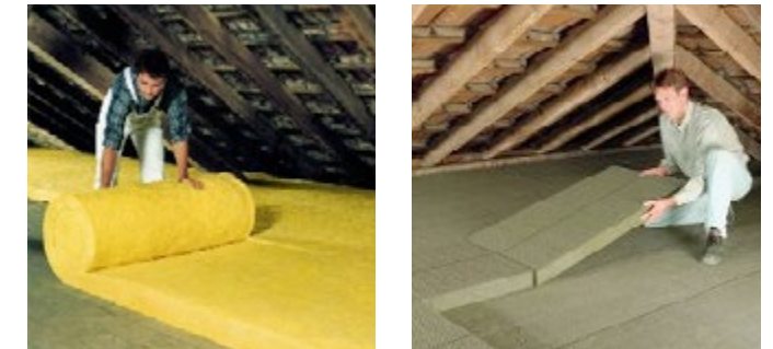
Abb. 51 / 52 Einbau einer Aufdeckendämmung aus Mineralfasern
