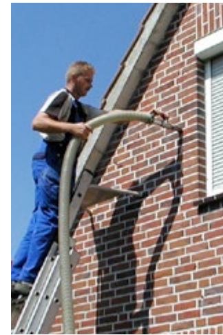
Abb. 80 Einbringen einer Einblasdämmung im Bestand
