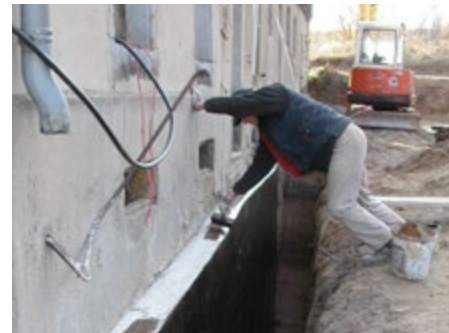
Abb. 107 Anbringen des Voranstriches für die folgende Bitumendickbeschichtung
