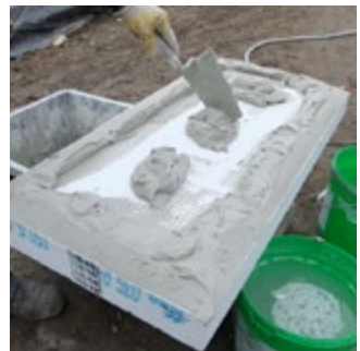
Abb. 68 Verklebung einer Sockeldämmplatte im Wulst-Punkt-Verfahren
