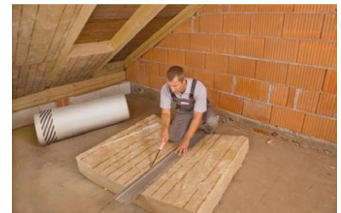
Abb. 29.1 Zuschneiden des Dämmstoffes
