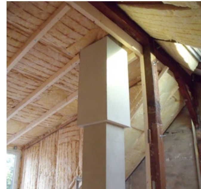
Abb. 25 Begleitdämmung eines massiven Schornsteinkopfes
