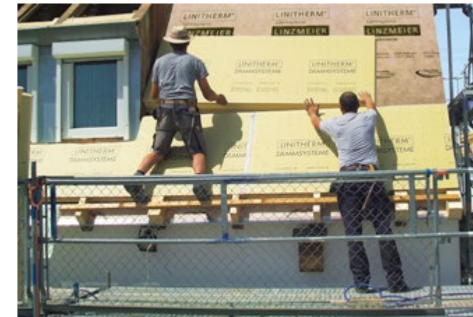
Abb. 37 / 38 Nachträgliche Dämmung von Schrägdächern in Kombination aus Auf- und Zwischensparrendämmung
