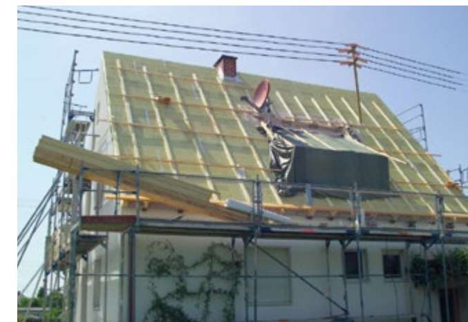
Abb. 35 / 36 Aufbringen einer Aufsparrendämmung aus Hartschaumplatten
