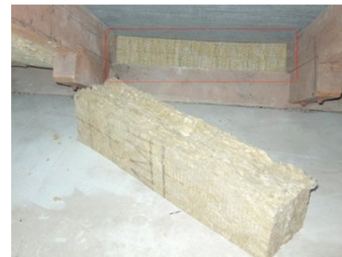
Abb. 26 kleiner Abschnitt der Dämmung, für schwer zu erreichende Stellen
