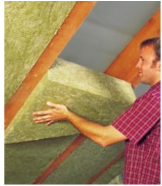
Abb. 29.2 Zwischensparrendämmung aus Dämmkeilen
