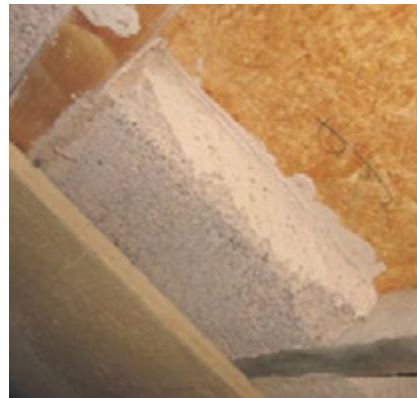
Abb. 41 Untersparrendämmung aus Wärmedämmlehm mit einer abschließenden Holzfaserplatte
