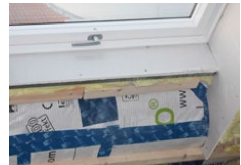
Abb. 43 Anschluss Dampfbremse an Dachfenster
