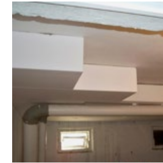
Abb. 102 Verkleidung der Decke mit 20 cm starken Dämmplatten
