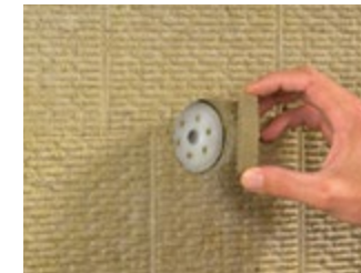
Abb. 73 - 75 Einschrauben und Versenken des Senkdübeln in einem Arbeitsgang, anschließend Einsetzen des Dübel-Rondells
