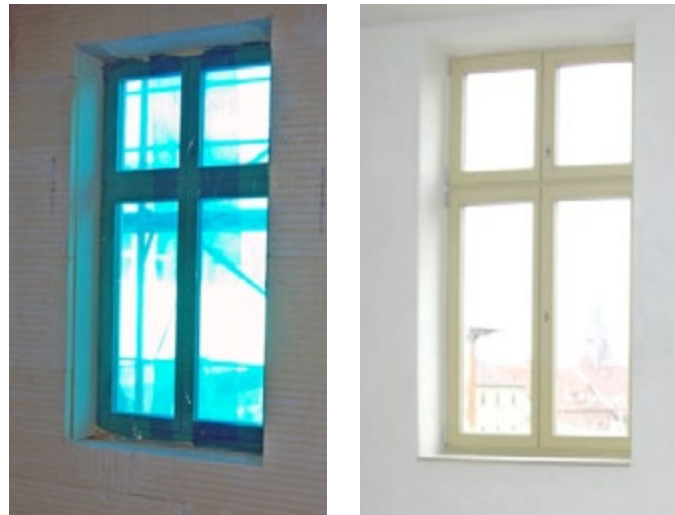
Abb. 88 / 89 Einsatz eines Innenwand-Dämmsystems unter Einbeziehung der Fensterlaibungen
