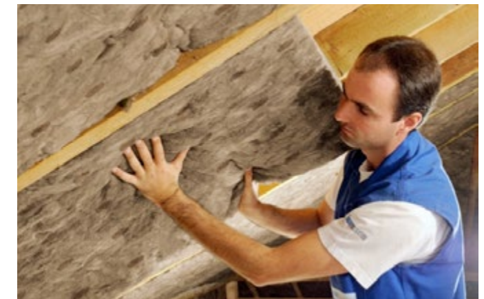
Abb. 28 Einbau einer Mineralwolldämmung zwischen den Sparren
