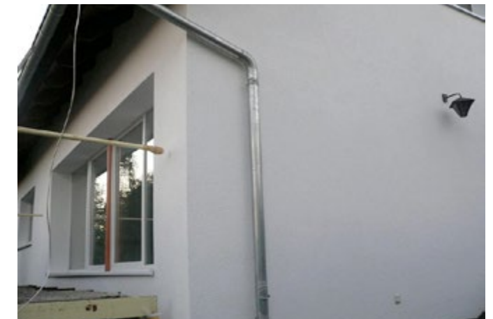
Abb. 66 / 67 Anbringen einer starken Außendämmung mit Lamellen aus Mineralwolle
