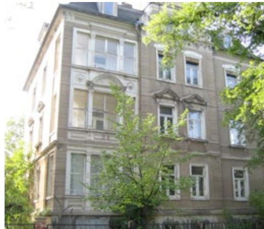
Abb. 91 Typische Kastenfenster und einfache Wintergarten- verglasung um 1900
