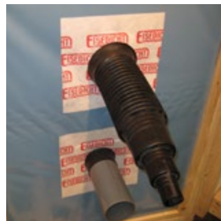
Abb. 49 Verwendung von Luftdichtungs- manschetten für verschiedene Rohrdurchführungen
