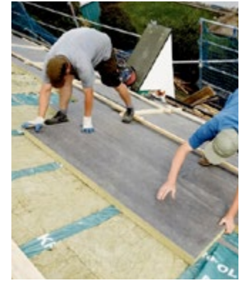
Abb. 37 / 38 Nachträgliche Dämmung von Schrägdächern in Kombination aus Auf- und Zwischensparrendämmung
