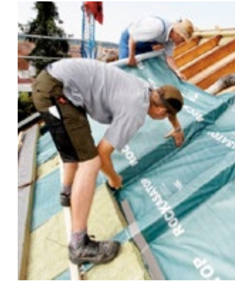
Abb. 37 / 38 Nachträgliche Dämmung von Schrägdächern in Kombination aus Auf- und Zwischensparrendämmung
