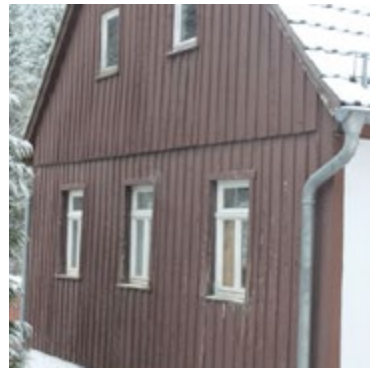
Abb. 78 / 79 Rekonstruktion einer landestypischen Holzverschalung
