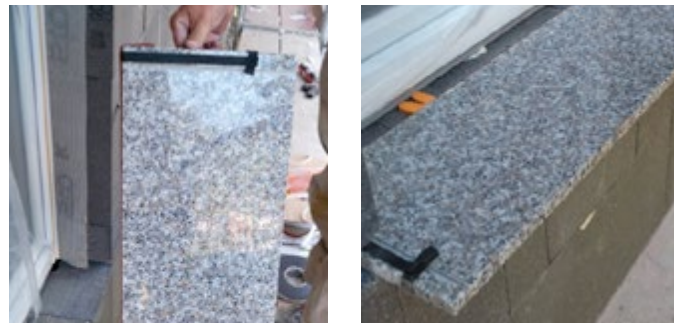
Abb. 97 / 98 Fensterbank mit aufgeklebtem Quellband
