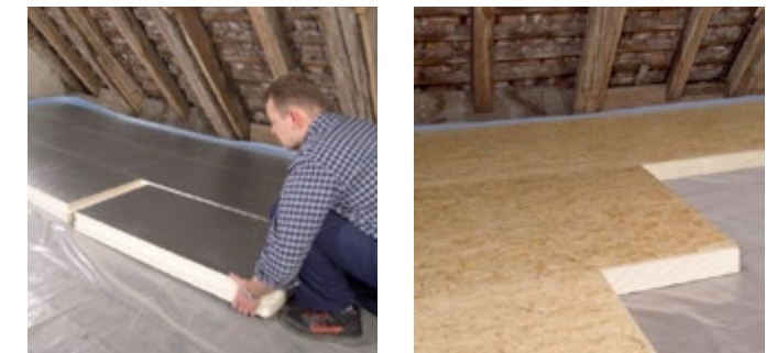
Abb. 53 / 54 Einbau von druckfesten Hartschaumplatten
