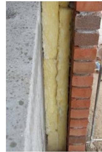
Abb. 81 Einbau einer Kerndämmung im Neubau
