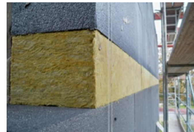
Abb. 19 Brandriegel aus Mineralwolle
