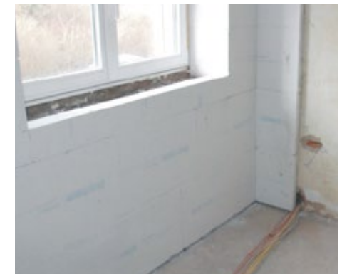
Abb. 86 Einsatz von Calciumsilikatplatten mit einer Flankendämmung an der einbindenden Innenwand
