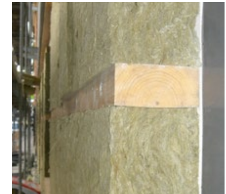
Abb. 76 Wärmedämmschicht zwischen der Holzunterkonstruktion
