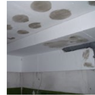
Abb. 101 Kellerdecken- und Flanken- dämmung der Innenwand
