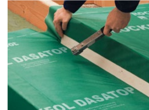
Abb. 39 Anbringen einer Anpresslatte für den Einbau der Dämmung ohne luftgefüllte Zwischenräume
