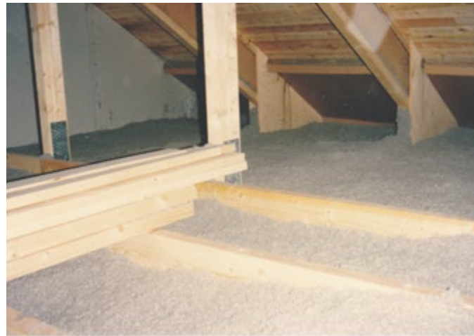
Abb. 55 Dämmung der obersten Geschossdecke mit Zellulose-Einblasdämmung
