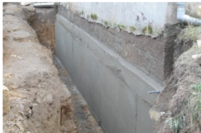
Abb. 106 Betonierte Vorsatzschale einer Kelleraußenwand
