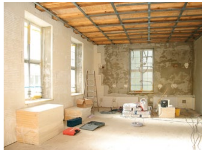
Abb. 84 / 85 Vollflächiges Verkleben einer kapillaraktiven Innendämmung
