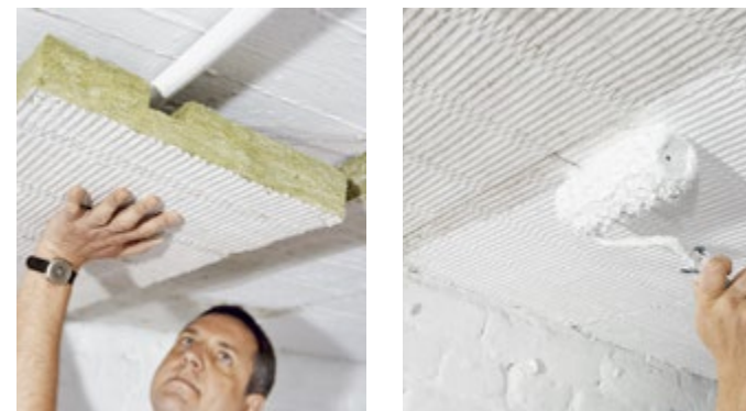
Abb. 99 / 100 Anbringen einer mineralischen Unterdeckendämmung
