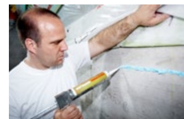
Abb. 44 Herstellen eines dauerhaft luftdichten Anschlusses der Dampfbremse an flankierende Bauteile mittels speziellem Dichtkleber
