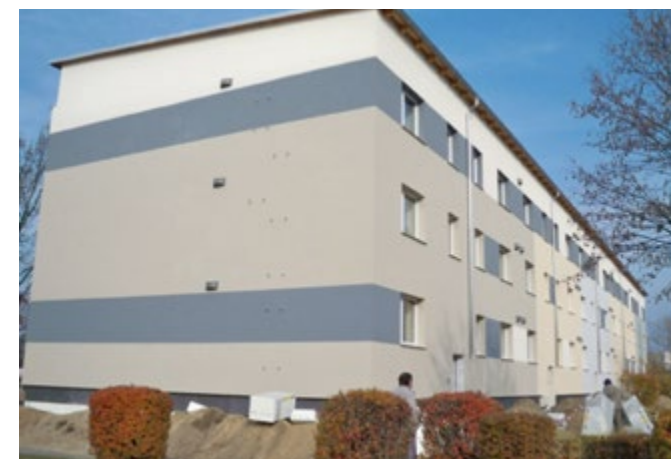
Abb. 64 / 65 Anwendung einer Außendämmung bei der Komplexsanierung eines „Plattenbaus“
