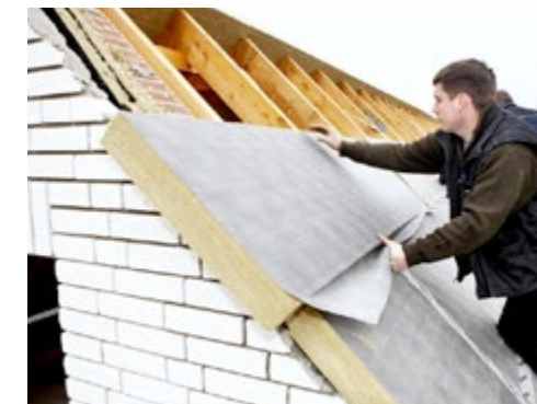
Abb. 40 Überdämmung des Ortgangs der Giebelwand
