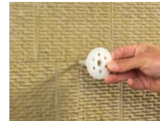
Abb. 73 - 75 Einschrauben und Versenken des Senkdübeln in einem Arbeitsgang, anschließend Einsetzen des Dübel-Rondells
