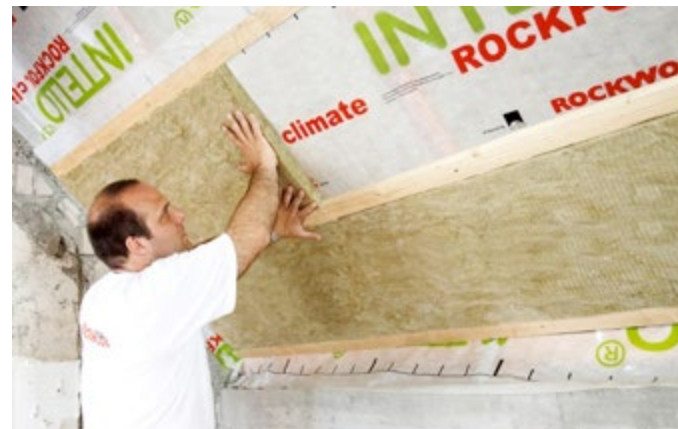
Abb. 33 / 34 Einbau einer Untersparrendämmung zwischen die Konterlattung
