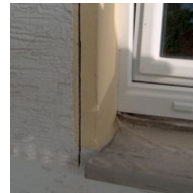
Abb. 94 Massiver Mauerwerksanschlag wird eingeschnitten und abgebrochen
