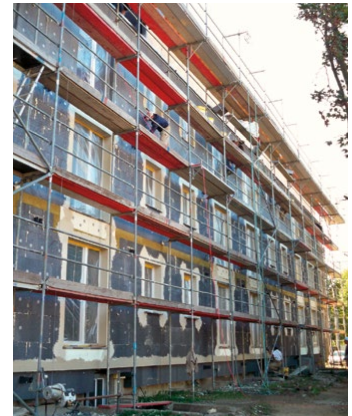
Abb. 20 WDVS mit umlaufenden Brandriegel
