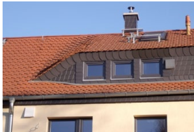
Abb. 21 Saniertes Dach mit Dachgaube
