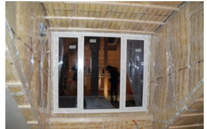
Abb. 42 Dachgaube mit umlaufend angeschlossener Dampfbremse
