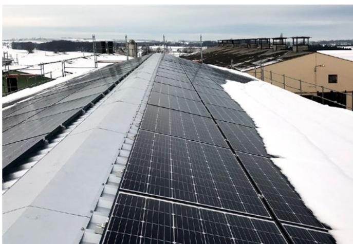
Abbildung 68: Schnee auf Solargenerator
