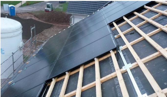
Abbildung 44: Indach-Montage mit Glas-Glas-Modulen
