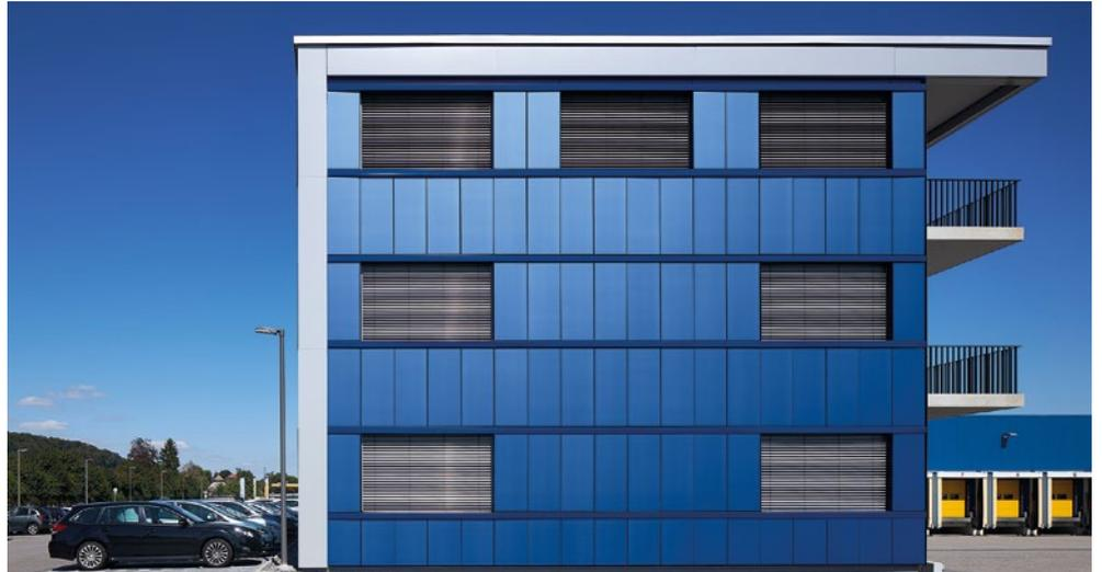
Abbildung 49: Fassadenanlage mit blauen Dünnschichtmodulen
