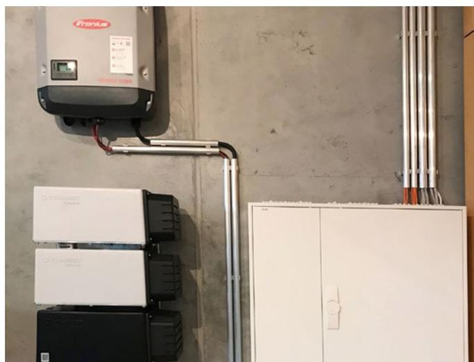
Abbildung 73: Modular erweiterbares Stromspeichersystem
