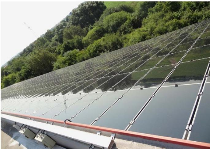
Abbildung 18: Aufdach-Anlage mit Dünnschicht-Modulen (CIS)
