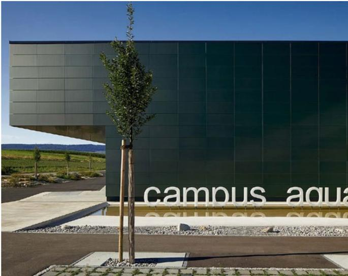
Abbildung 17: Fassade mit grünen Dünnschichtmodulen (CIS)
