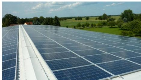
Abbildung 39: Dachparallele Montage auf Trapezblech
