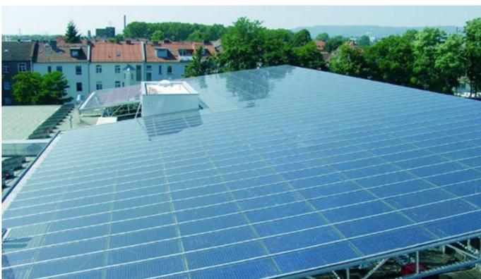
Abbildung 52: Überdachung mit Solar-Glas
