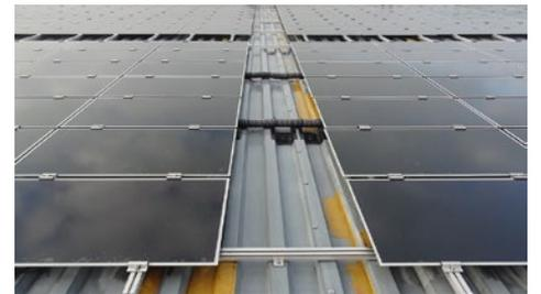
Abbildung 37: Montage auf Trapezblechdach
