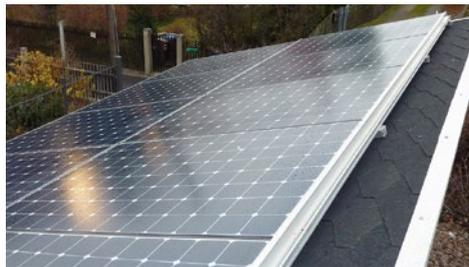
Abbildung 36: Montage auf Bitumenschindeln
