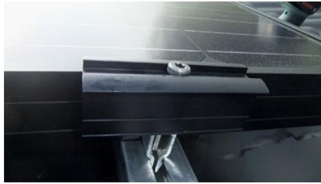
Abbildung 33: Modulklemme zur Fixierung von PV-Modulen
