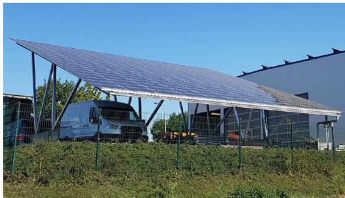
Abbildung 55: Solar-Carport mit Dünnschicht-Modulen
