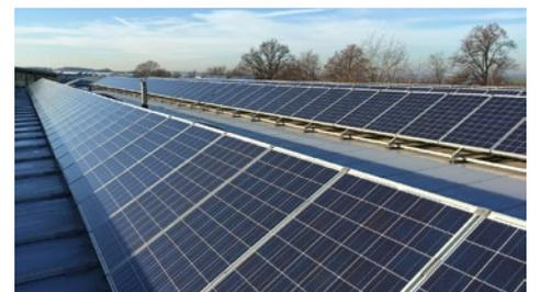
Abbildung 43: Aufgeständerte Montage mit Aluminium-Gestellen auf Blechdach
