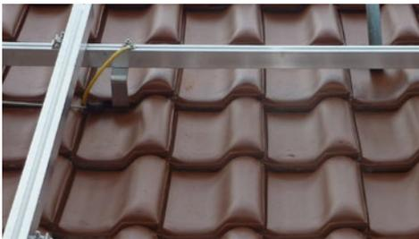
Abbildung 35: Anschluss Potentialausgleich am Befestigungssystem
