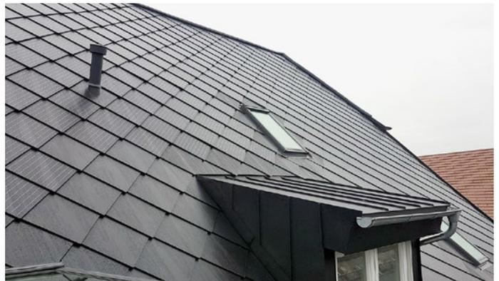
Abbildung 47: Solardachziegel in Dachschieferoptik
