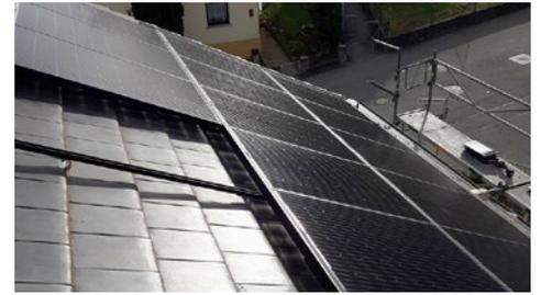
Abbildung 34: Modulbefestigung mit K2 Systems Einlegesystem
