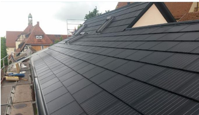
Abbildung 46: Solardachziegel in Flachziegeloptik
