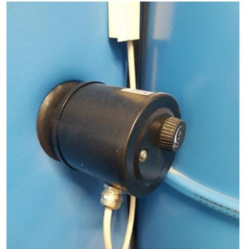
Abbildung 91: Nicht regelbarer Heizstab mit 2 kW in einem Pufferspeicher
