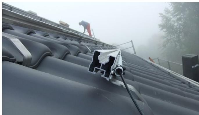
Abbildung 23: Verlegung von Solarkabeln in Schutzrohren
