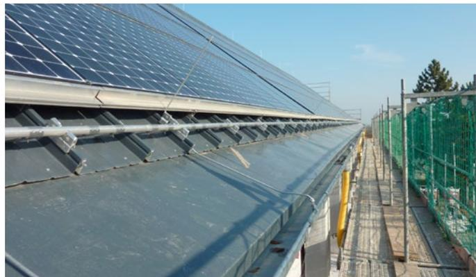
Abbildung 107: Installation von Photovoltaik- und Blitzschutzanlage
