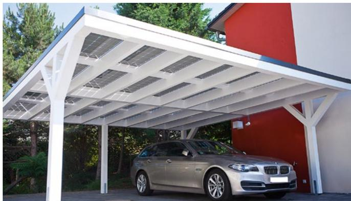
Abbildung 54: Solar-Carport mit Glas-Glas-Modulen
