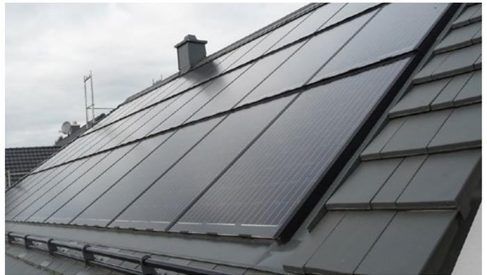
Abbildung 45: Fertige Indach-Anlage mit Glas-Glas-Modulen
