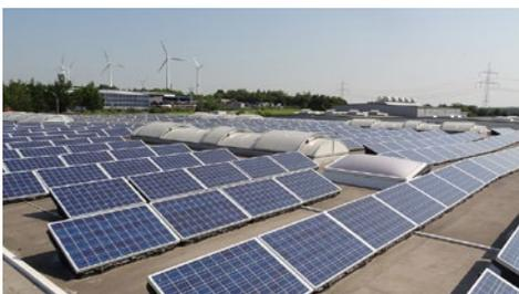
Abbildung 41: Aufgeständerte Montage mit Kunststoffwannen
