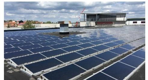
Abbildung 40: Aufgeständerte Montage mit Kunststoffwannen
