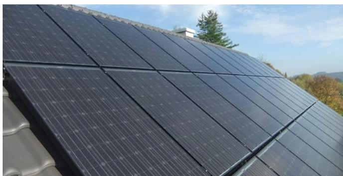
Abbildung 11: Aufdach-Anlage mit monokristallinen Dickschichtmodulen
