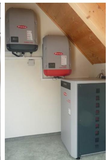
Abbildungen: 76 / 77: Installierte Solarstrom-Speichersysteme
