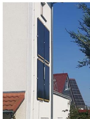
Abbildung 57: Mini-PV-Anlage an einer Fassade
