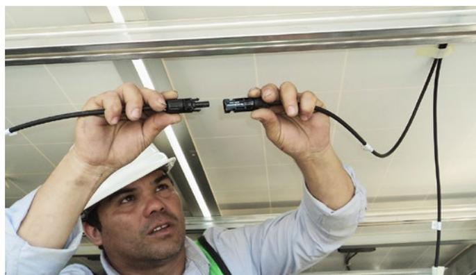
Abbildung 24: Verbindung von Solarmodulen mit MC4-Steckverbinder
