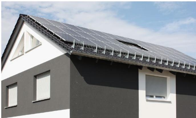
Abbildung 29: Aufdach-Montage eines Solargenerators
