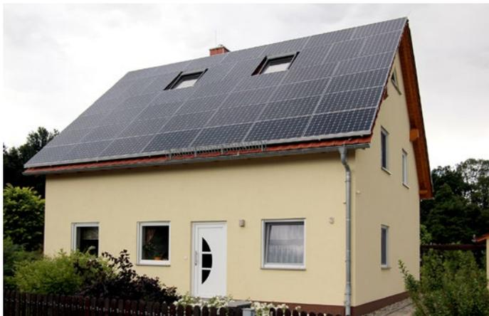
Abbildung 109: Optimale Dachausnutzung trotz Dachfenstern
