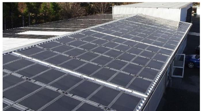
Abbildung 19: Aufdach-Anlage mit Dünnschichtmodulen (CIGS)
