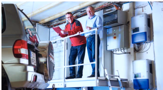
Friedhelm Bilsing (li.) und Frank Demmler in der Energie-Steuerzentrale
