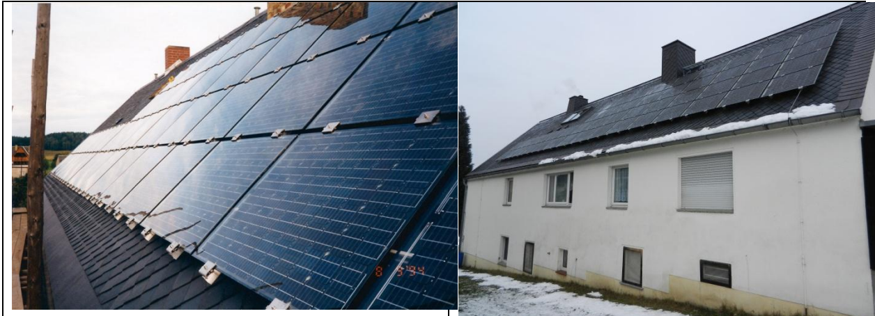
Bild 64: PVA Schönteichen (links: Aufnahme bei Inbetriebnahme, rechts: aktueller Zustand)
