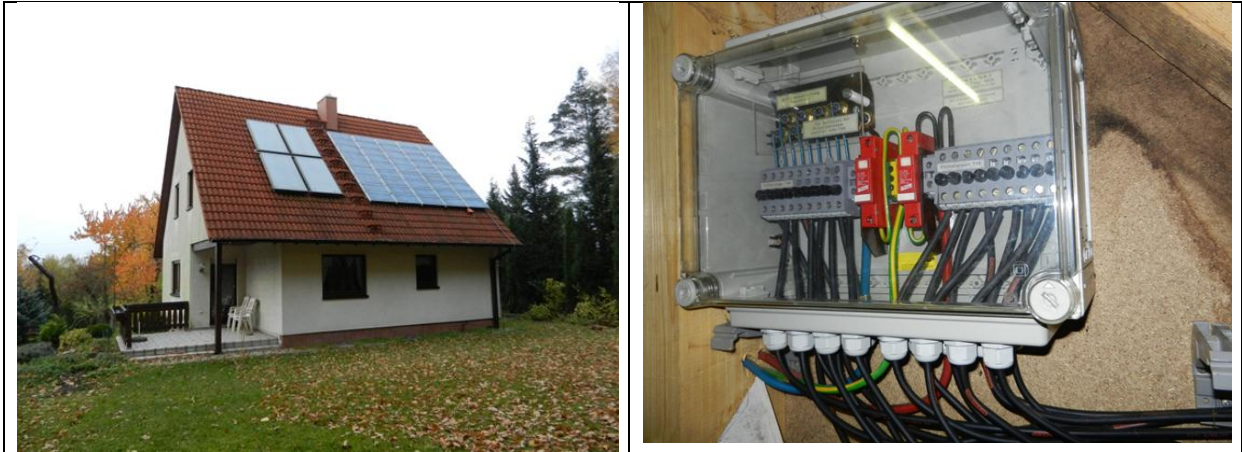
Bild 54: PVA Niesky; rechts Generatoranschlusskasten
