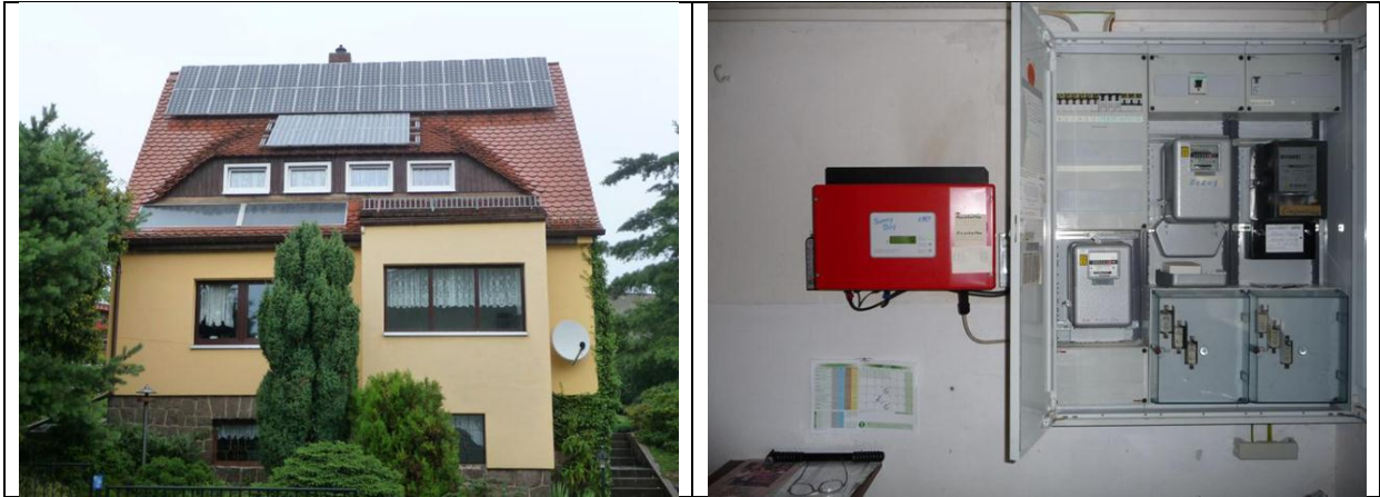
Bild 44: PVA Radebeul, rechts Wechselrichter und Zählerplatz
