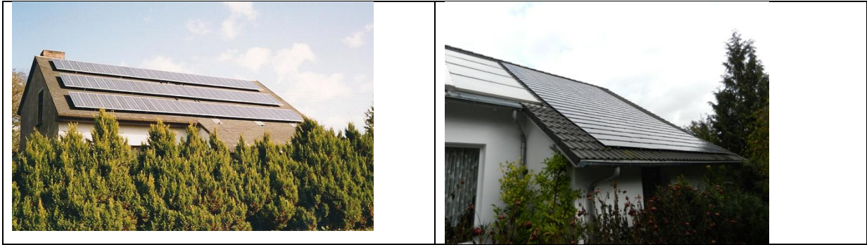
Bild 40: PVA Jahnsdorf (links: Originalzustand, rechts: nach Umbau)
