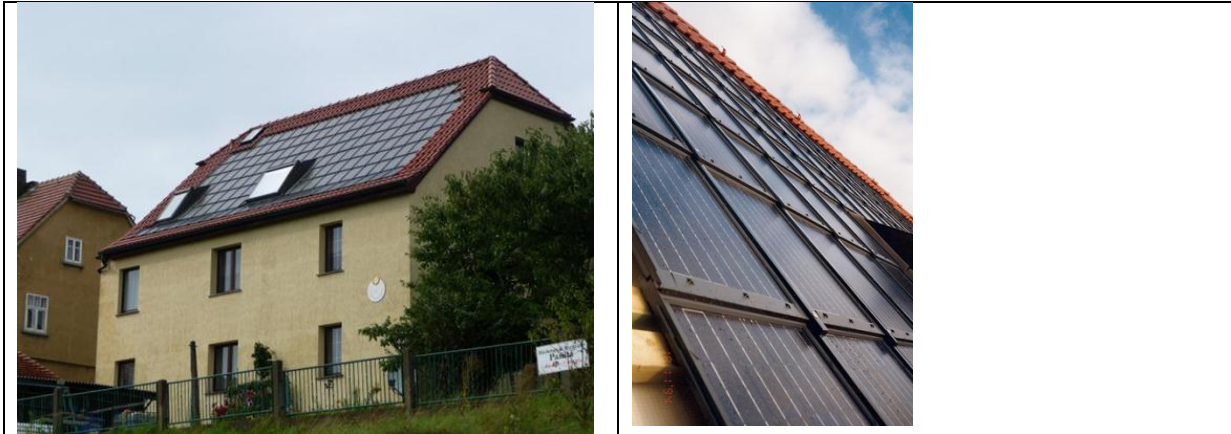
Bild 48: PVA Kirschau II; rechts Detail der Solar-Dachziegel bei Montage
