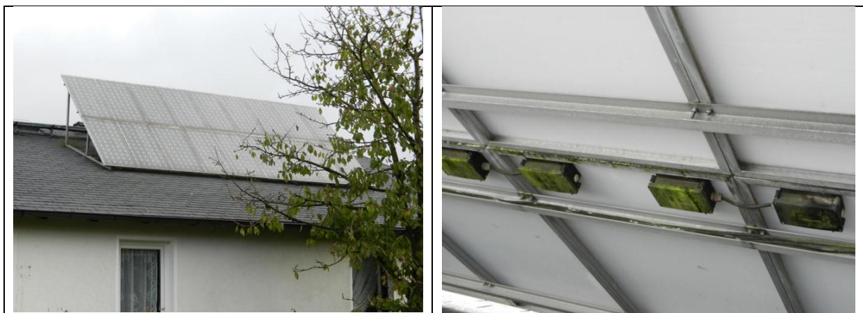
Bild 61: PVA Mühlental; rechts Moduldosen
