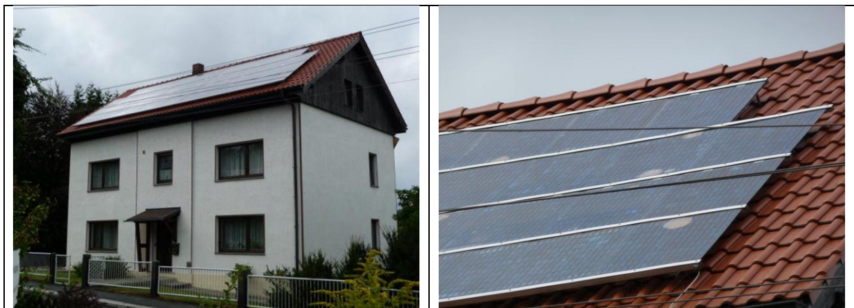
Bild 57: PVA Kirschau I; rechts sichtbare Delaminationserscheinungen
