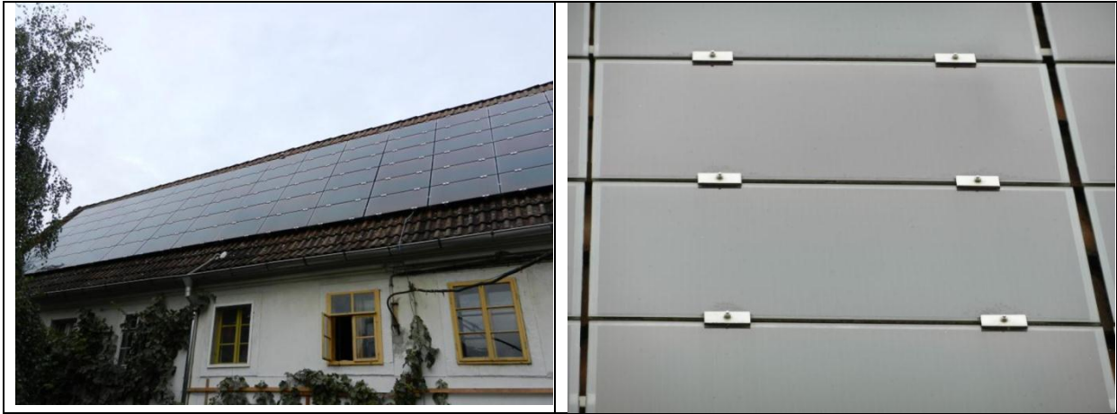
Bild 67: PVA Dresden X; rechts Detail der weitgehend strukturlosen Dünnschichtmodule ASI
