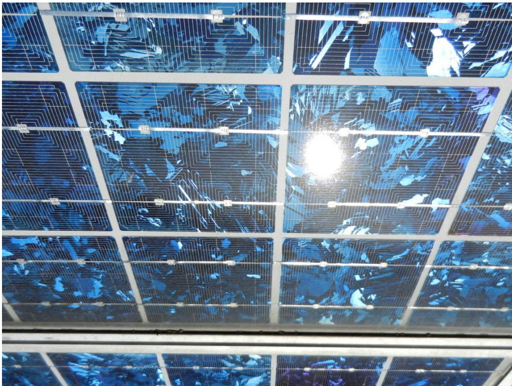
Bild 17: Typische polykristalline Struktur der Module von Photowatt (PVA Aue). An der Unterkante der Module sind leichte Verschmutzungen erkennbar.
