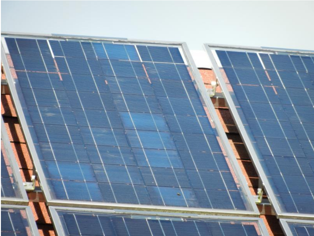
Bild 15: Optische Auffälligkeiten der Solarzellen eines nach Garantie erneuerten MQ-36-Moduls (PVA Rosenthal-Bielatal) blieben ohne Auswirkungen auf den Ertrag.
