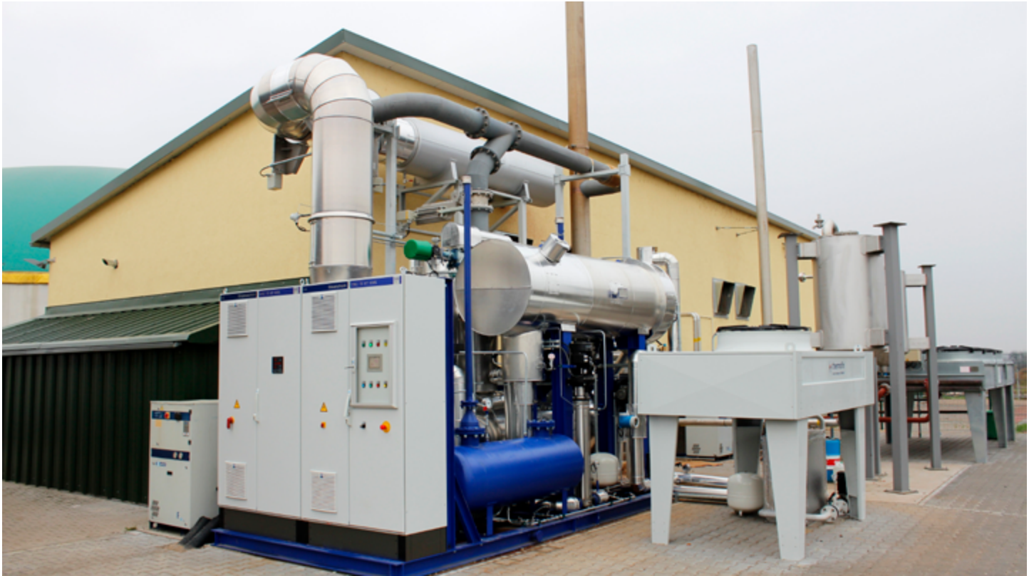
Abb. 37: ORC-Anlage [70 kW elektrisch, von Dürr Cyplan] zur Nutzung der Abgaswärme eines Biogas-Blockheizkraftwerks.
