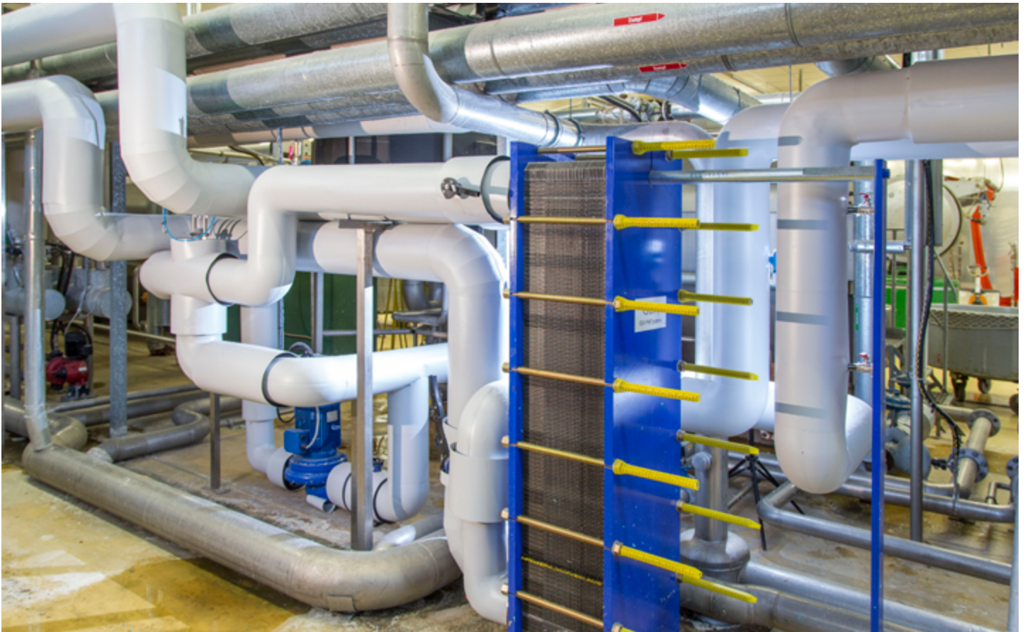
Abb. 2: Nutzung der Abwärme aus einem Blockheizkraftwerk mittels Plattenwärmeübertrager (S. 15) bei Frottana Textil GmbH & Co. KG in Großschönau (Lausitz)
